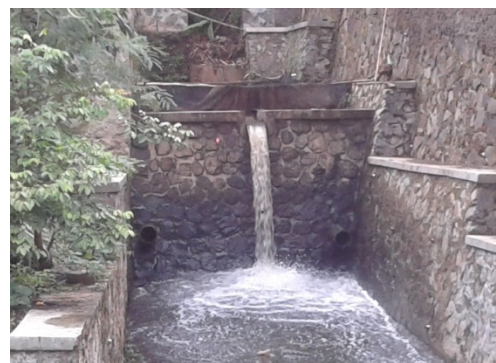
Gambar 5. Potensi sumber energi air yang akan dimanfaatkan.
